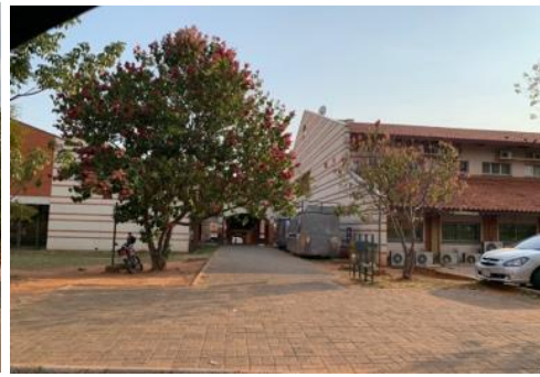
Imagen 8 Acceso a corredores de las instalaciones hospitalarias. Elaboración propia.
