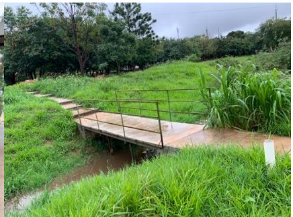
Imagen 17 Puente de la laguna del área verde de Clínicas. Elaboración propia.
