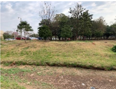
Orillas; taludes estables.
