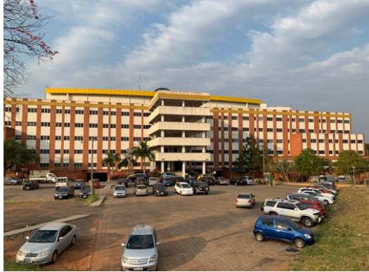
Imagen 10 Fachada principal del nuevo Hospital de Clínicas. Elaboración propia.
