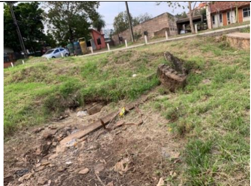
Presencia de sedimentos y residuos.
